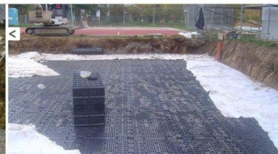
2、铺敷防水膜，把模块进行堆放结合。
