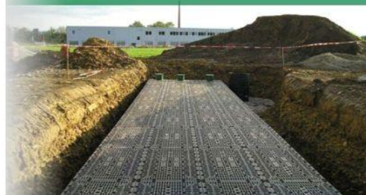
3、防水膜包裹后将四周回填夯实，顶部回填种植土或砂石土，恢复植被。
