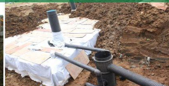
3、防水膜包裹后将四周回填夯实，顶部回填种植土或砂石土，恢复植被。
