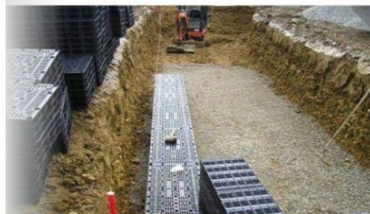
1、挖掘合适的基坑并夯实。
